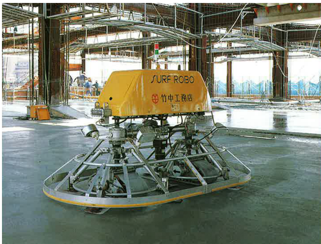
Glättningsrobot från Takenaka Corporation.
